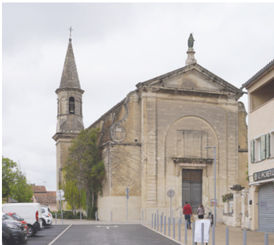
Réalisation de travaux d'étanchéité à l'église Saint-André
